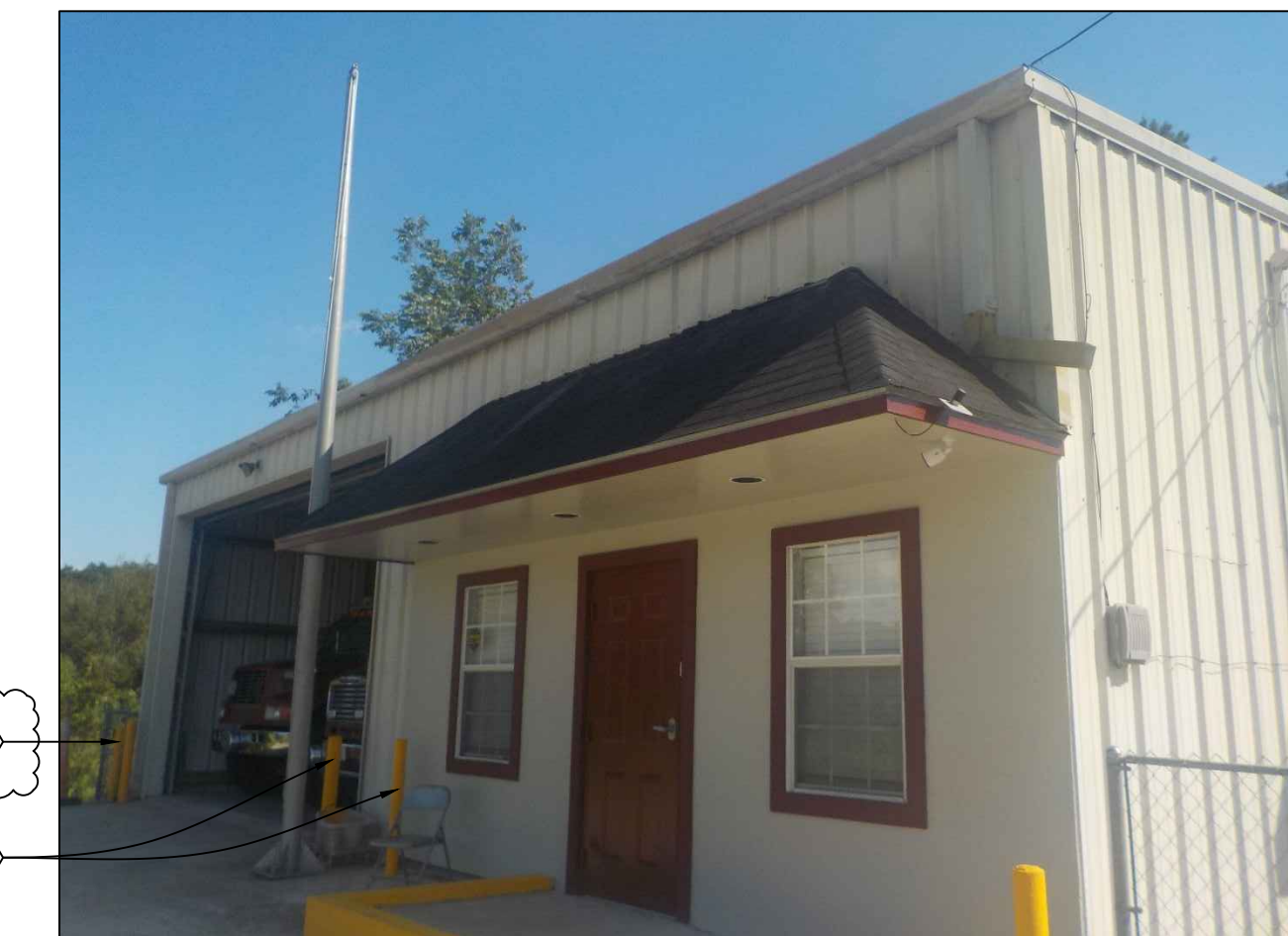
3 EXISTING BUILDING SCALE: N.T.S.
