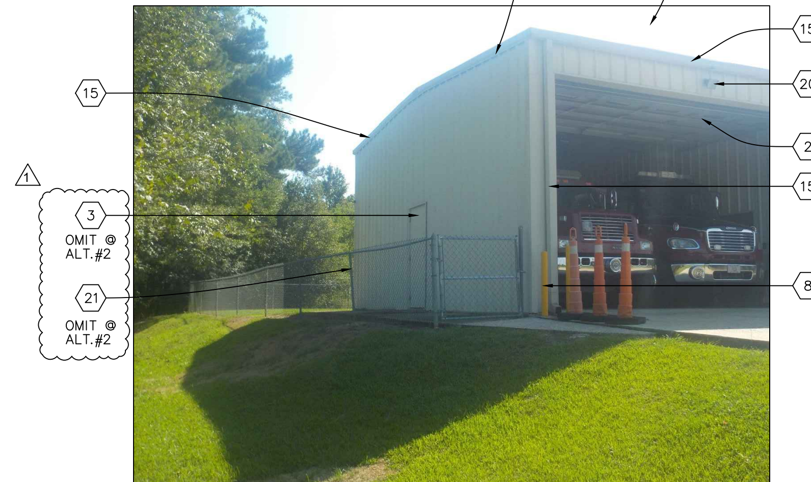
4 EXISTING BUILDING SCALE: N.T.S.
