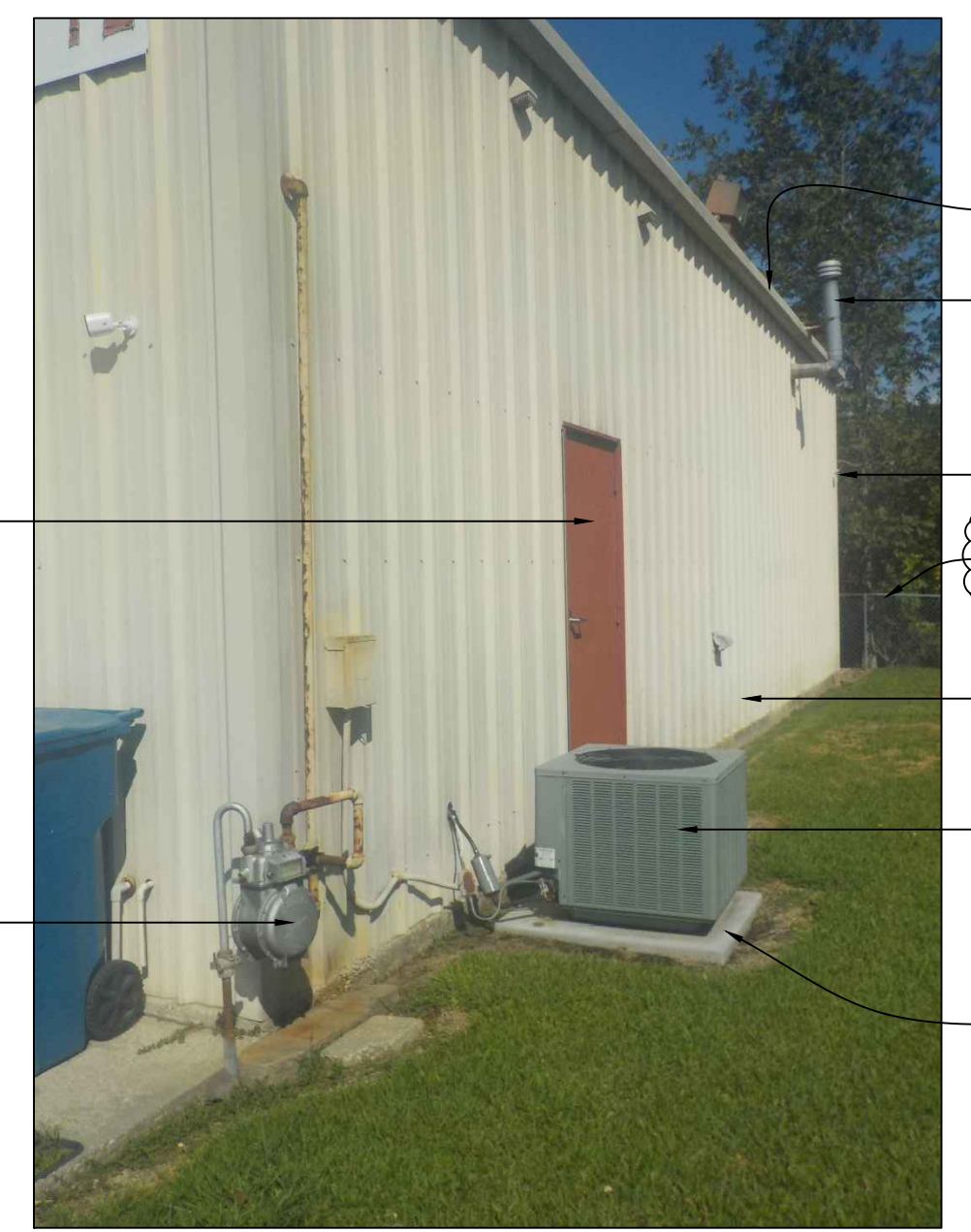
2 EXISTING BUILDING SCALE: N.T.S.
